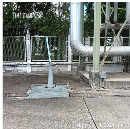
ภาพที่ 2-12 ประตุน้ำตึงและน้ำฝนของโครงการ
