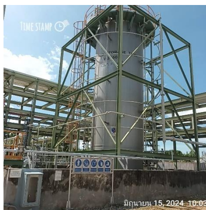
ภาพที่ 2-27 ถังเก็บสารละลายแอมโมเนียมไฮดรอกไซด์เหลว
