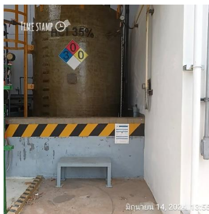
ภาพที่ 2-26 คันคอนกรีตป้องกันการทกรั่วไหลของสารเคมี
