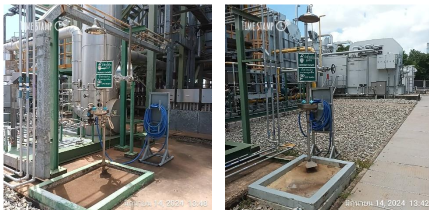
ภาพที่ 2-25 อ่างล้างตาและฝักบัวฉุกเฉิน
