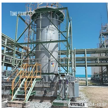
ภาพที่ 2-27 ถังเก็บสารละลายแอมโมเนียมไฮดรอกไซด์เหลว
