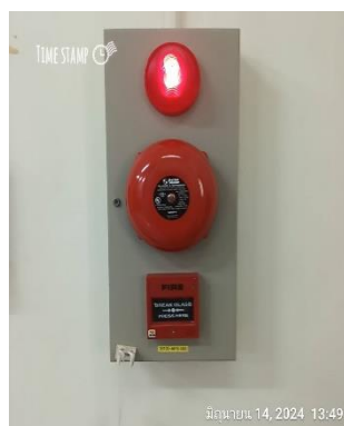
ภาพที่ 2-33 ตัวอย่างอุปกรณ์เตือนภัยและระงับเหตุฉุกเฉินของโครงการ
