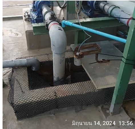
ภาพที่ 2-10 ถังปรับสภาพ (Neutralization Basin) (ใต้ดิน)
