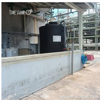
ภาพที่ 2-26 คันคอนกรีตป้องกันการทกรั่วไหลของสารเคมี
